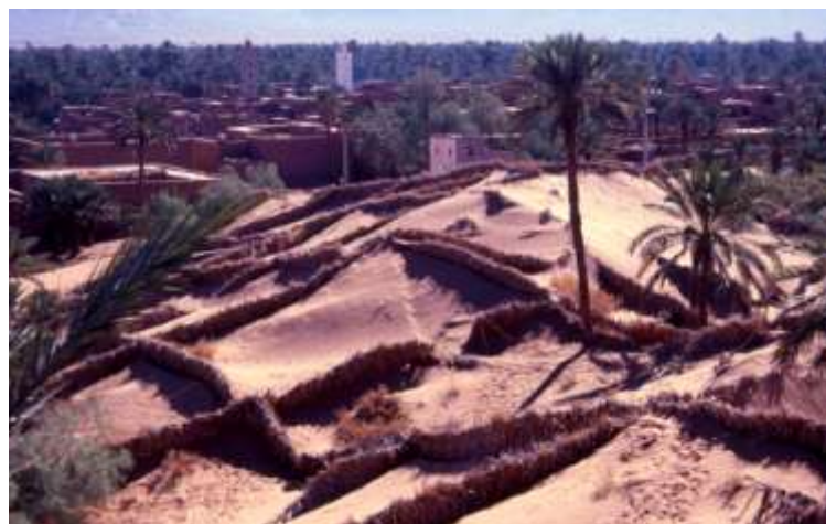
Figure 19 : Chantier de défense et de restauration à la limite des oasis, dans le Draa moyen
