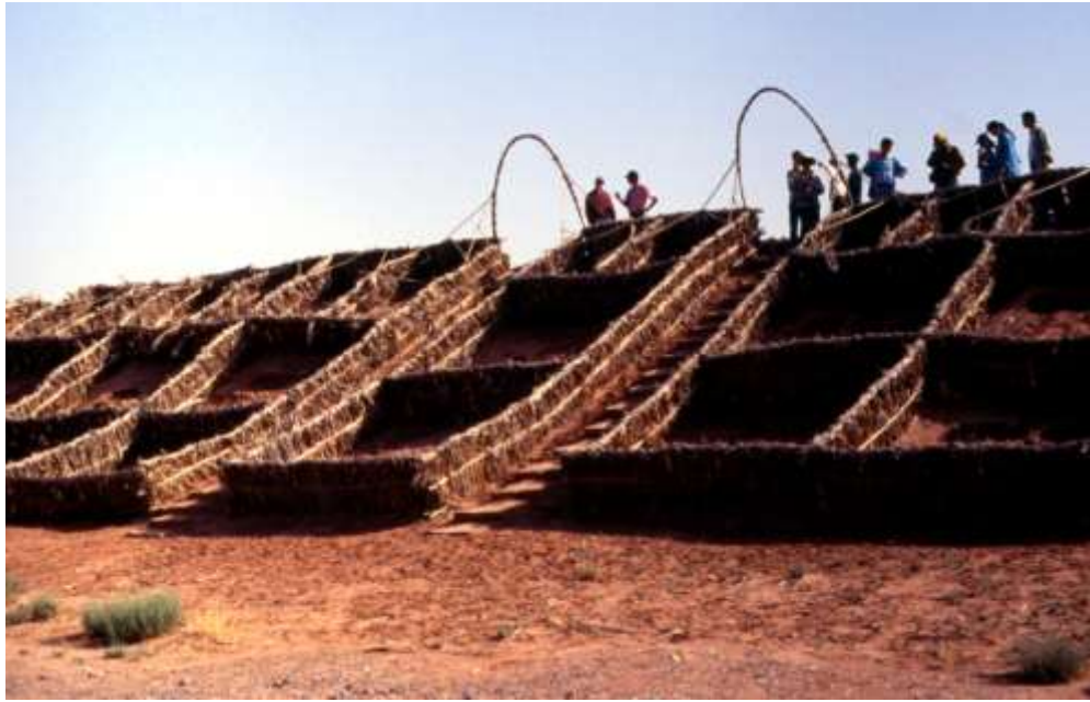
Figure 18 : Chantier de fixation de dunes dans le Tafilalet, en palmes tressées et végétalisation adaptée.
