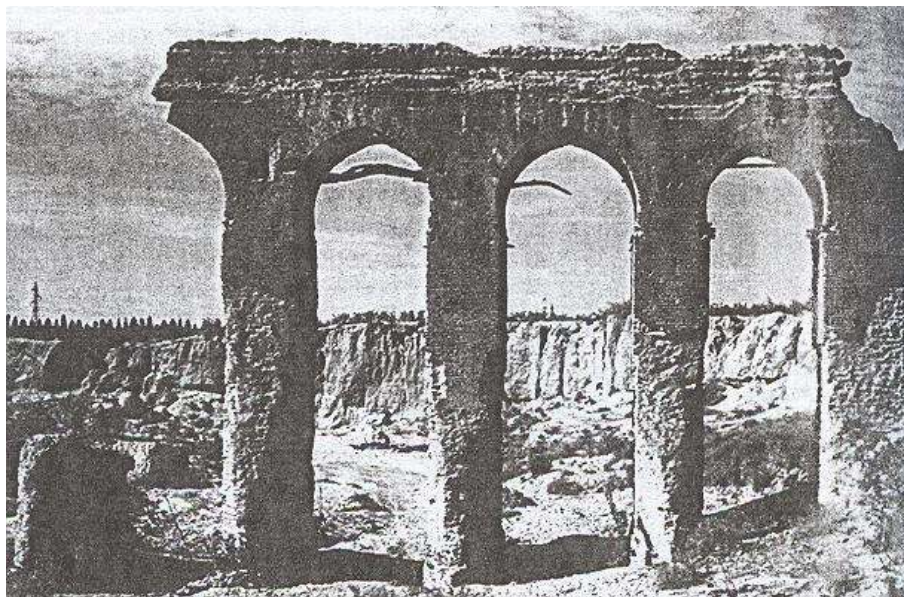
Figure 26: Aqueduc de l'Oued El Ouaâr, près de Taroudant, (cliché Boujnikh, 2008)
