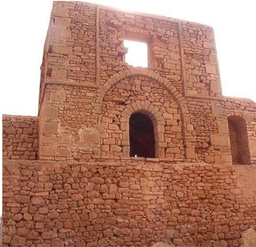
Une ouverture dans une façade constitue un point vulnérable en cas de déformation du bâti. Très souvent sur des constructions anciennes, des arcs en pierre taillée situés au dessus d'une ouverture.
